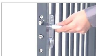
2. Подтянуть болты для устойчивой фиксации замка в калитке.
