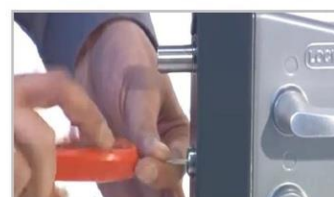
8. Затянуть крепление замка в калитке, установить пластиковые заглушки.
